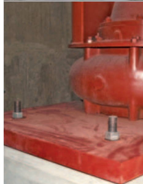
Bauteil montieren und Montage Drehmoment mittels geeichtem Drehmomentschlüssel aufbringen
